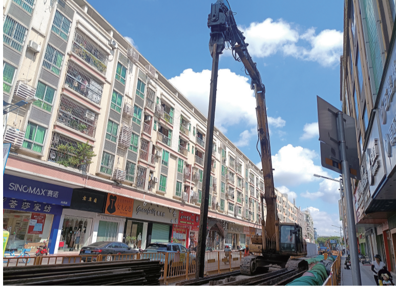
工程正在进行施工。
