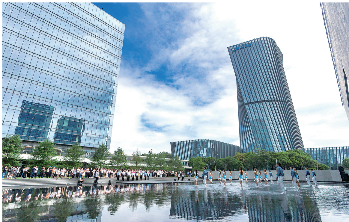
总投资近20亿元的“美的08空间”正式启用。/顺德融媒记者何冠洪摄
