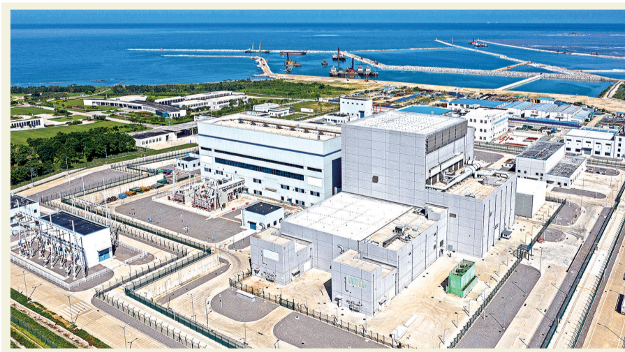
国有企业狠抓传统产业升级和战略性新兴产业培育壮大。图为华能青岛湾高温气冷堆示范工程外景。/新华社发
