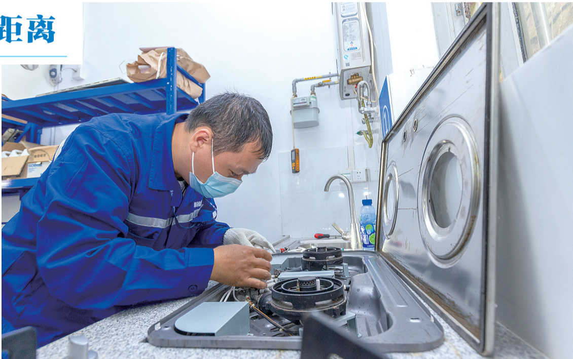
顺德港华燃气职工进行入户通气检修作业。/顺德融媒记者周焯杰摄
