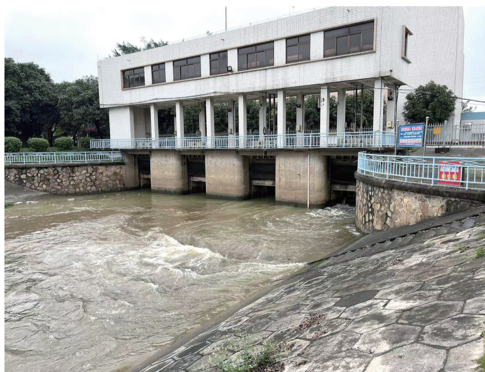
4月8日,顺德区住房城乡建设和水利局组织跨镇街应急排涝演练。图为大门泵泵站进行强排水。/受访单位供图
