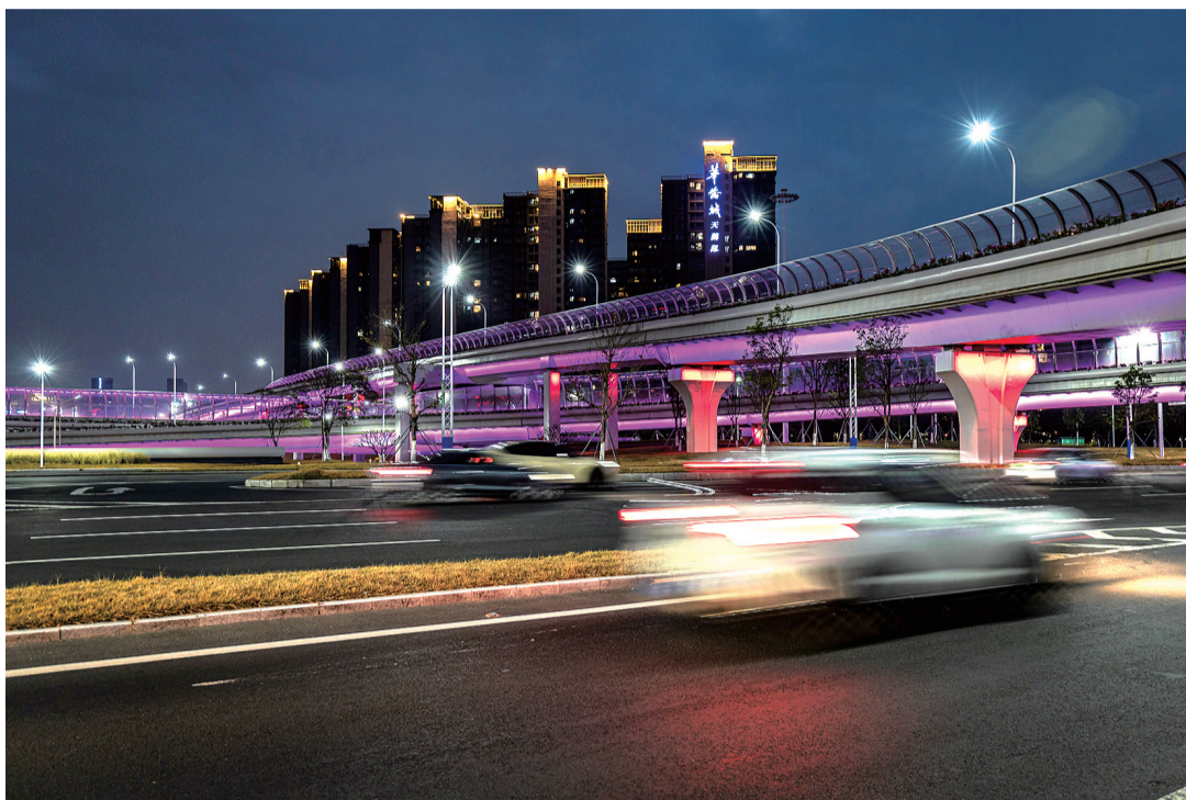
2月27日,顺德区碧南立交美化亮化工程于近期完工。/佛山市新闻传媒中心记者林安迪摄
