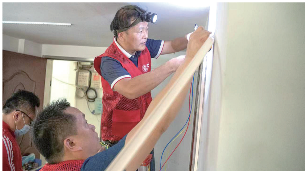
兴乐社区居家助困志愿服务队为困难家庭更换老化电线。/兴乐社区供图
