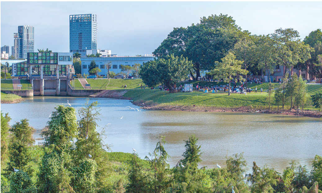
位于顺德区平洲水道东岸的陈村美岸示范项目。
