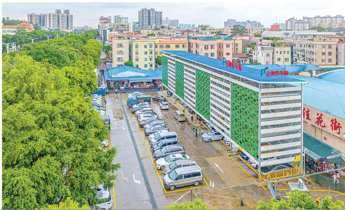
容桂街道上佳市立体停车库。/佛山市新闻传媒中心记者蔡奕昶实习生苏伟铨摄
