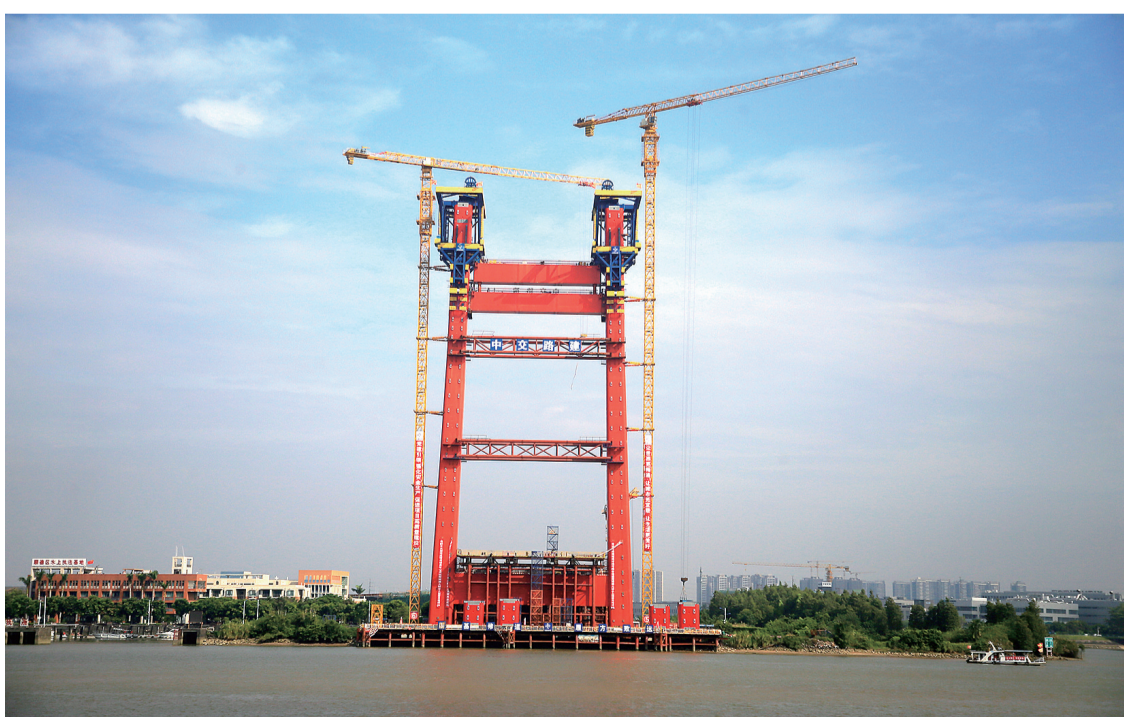
上周,顺德大桥顺利完成容桂侧高塔封顶,预计在2025年上半年完工通车。/佛山市新闻传媒中心记者陈炳辉摄
