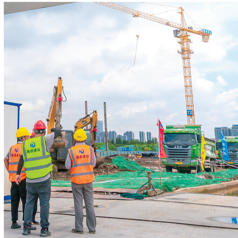
执法人员检查工地起重机械。(佛山市新闻传媒中心记者何冠洪摄)
