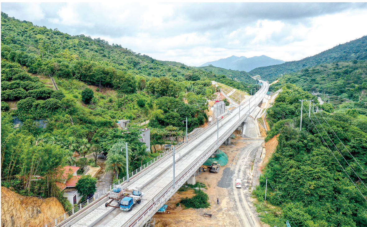
广汕高铁迎牌山隧道口已经建设完成无砟轨道示范段。/新华社发
