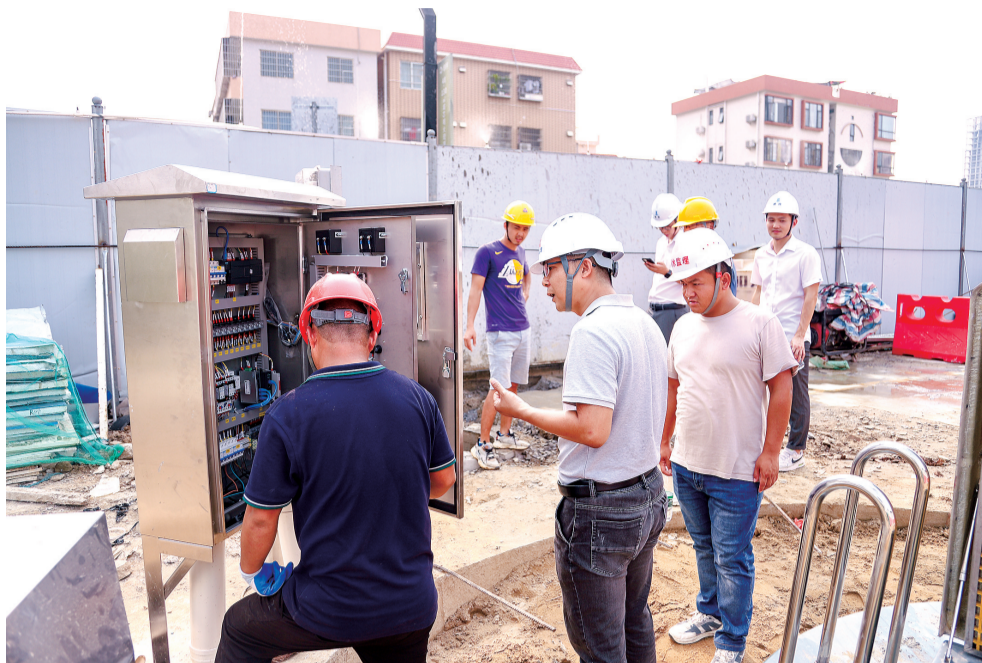
图为施工现场。/大良宣办供图
